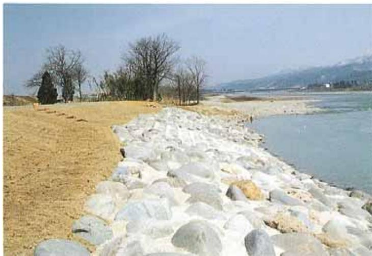
自然石を使ったものの、水際を固めたため空隙がなく生物の生息・生育環境を悪化させてしまった。
