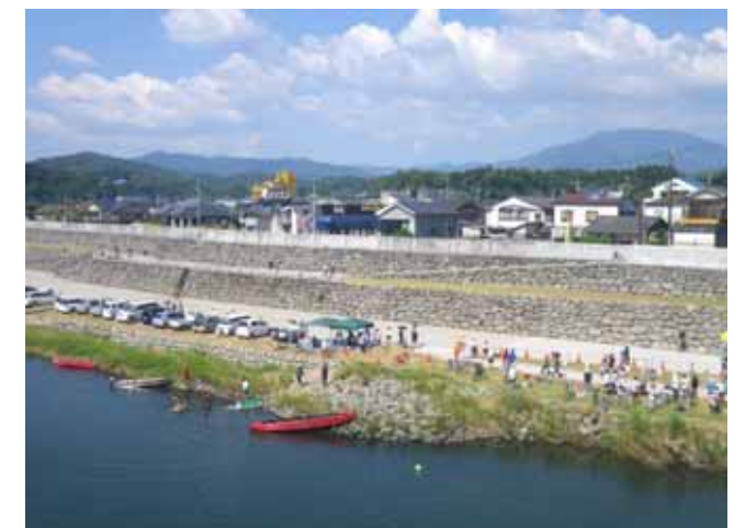
河川の利活用の利便性や景観にも配慮した新しい河川空間が誕生
