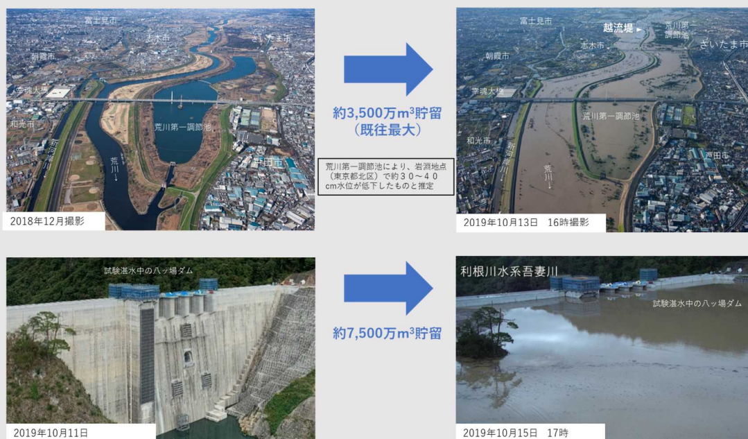
図 4-6 2019 年東日本台風における荒川第一調整池および試験湛水中のハッ場ダムの効果 72
