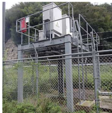
図 4-3 電気設備のかさ上げ事例 70
