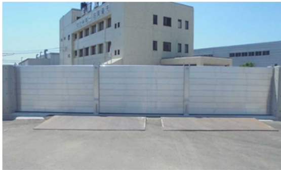
図 4-2 止水壁（アルミパネル）の設置による浸水防止の効果発揮事例 70
