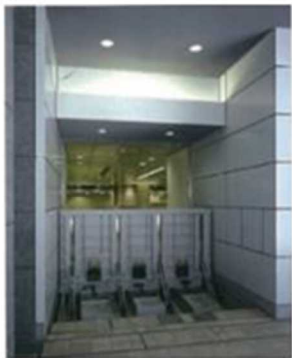
【ビルの出入口の止水板】
