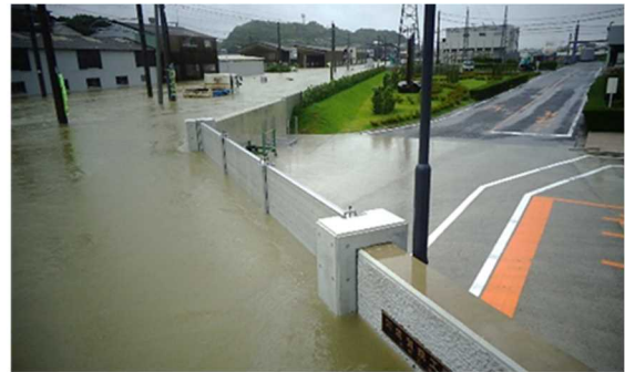
図 4-2 止水壁（アルミパネル）の設置による浸水防止の効果発揮事例 70
