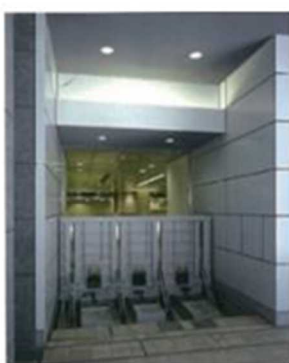
【ビルの出入口の止水板】
