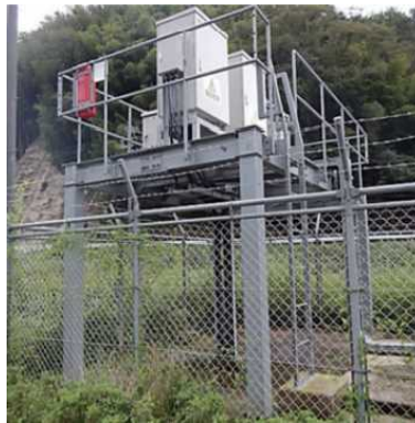
図 4-3 電気設備のかさ上げ事例 70
