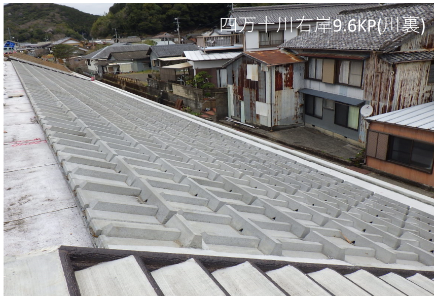
コンクリートブロック張り: 13箇所 ※ブロックマット: 1箇所 (桂川)
