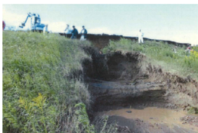
損傷事例 (吉田川L14.8k)
