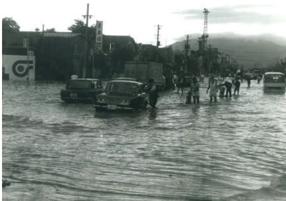
写真－① S. 44 年 8 月 国道 4 号浸水状況
