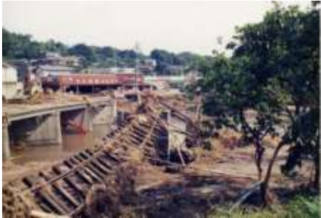
写真 1.9 JR豊肥本線鉄道橋の流出（平成 2 年 7 月梅雨前線豪雨）
