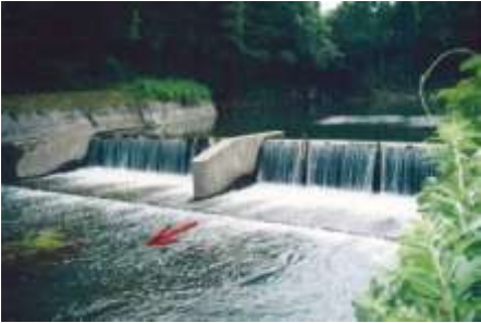
写真 1.11 龍宮井路頭首工
