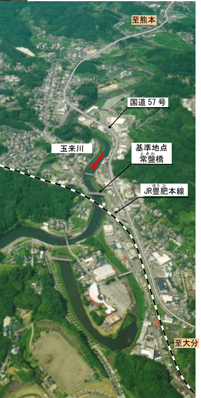
写真 1.5 玉来川下流部の状況(竹田市街地部)
