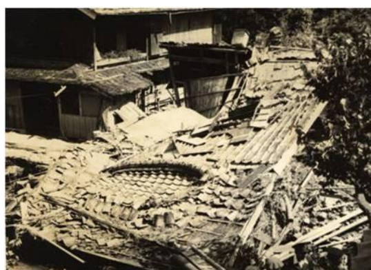
②倒壊した家屋（若狭町河内）
