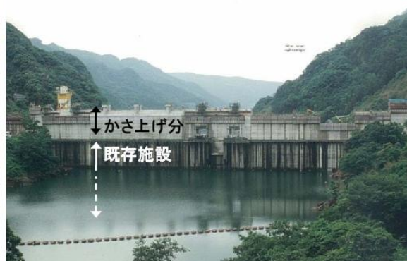
ダムかさ上げ
