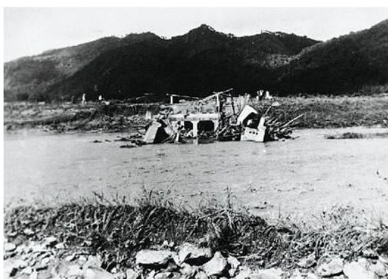
①橋の流失状況（小浜市）
