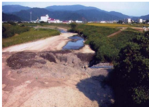
河川を掘削して伏流水を利用（若狭町天徳寺付近）
