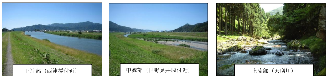
図- 2.19 北川河川状況
