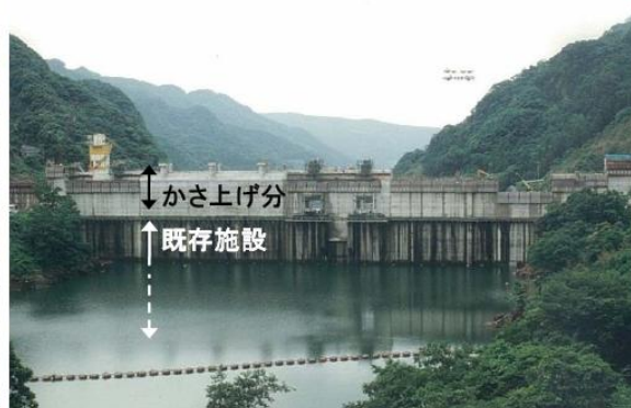
ダムかさ上げ
