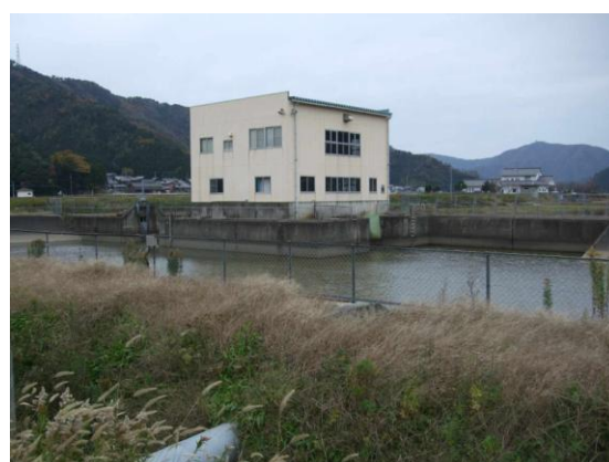
②鳥羽第一揚水機場
