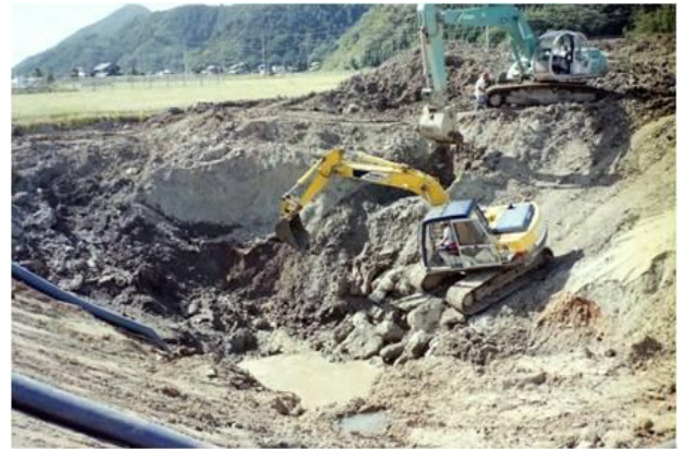
水田つぶし地下水掘削（世野見井堰）
