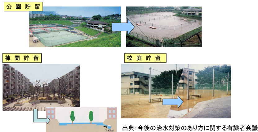
図 4.3.14 雨水貯留施設のイメージ
