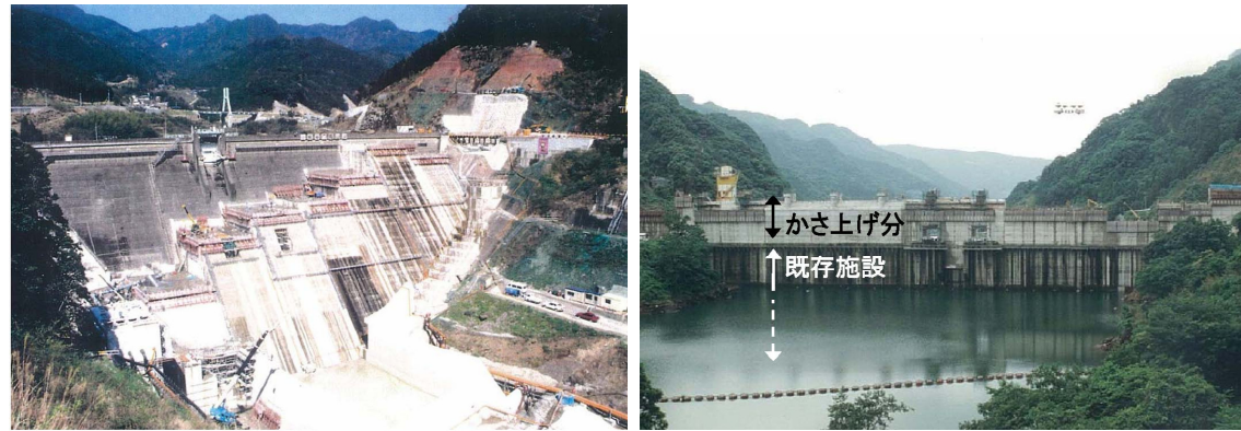
図 4.3.4 ダムの有効活用のイメージ（ダムのかさ上げ）
