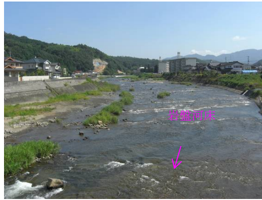
【下流部】車橋から上流 (No.1)
