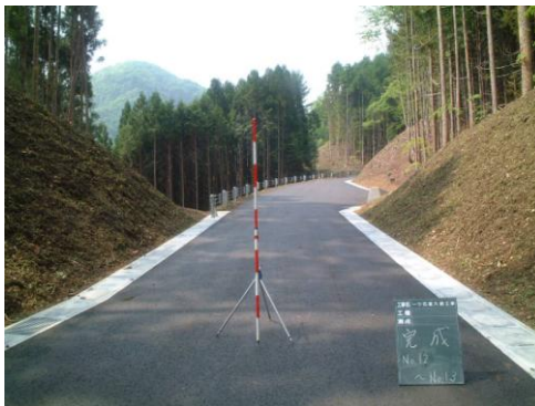
＜工事完成直後＞
