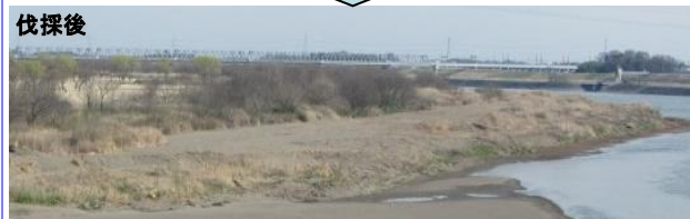
※伐採後に河道掘削
