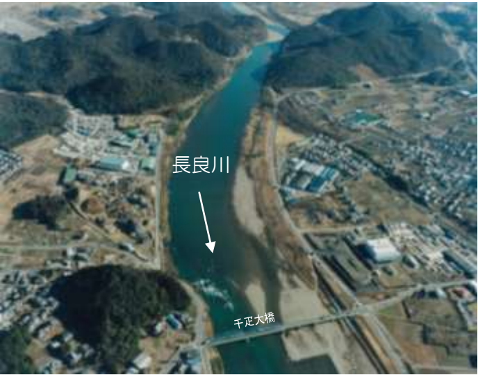
III：千足大橋付近（関市）
