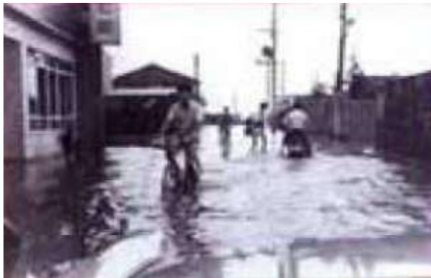
写真- 3 北摂豪雨 (S42. 7) の被害状況 (茨木市沢良宣)
