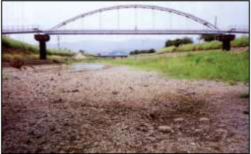
写真- 6 平成 12 年渇水状況 (千歳橋付近)
