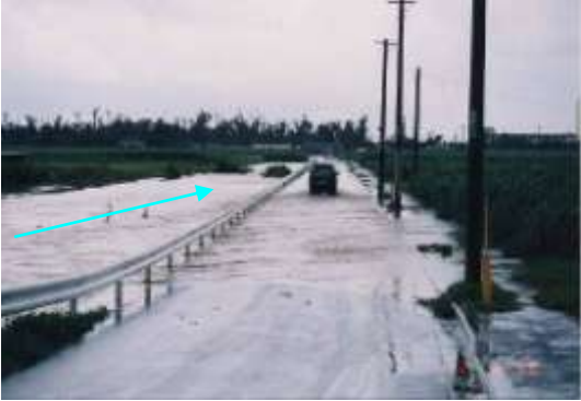
図－1.2 下流部の氾濫状況 平成 10 年 10 月
