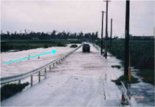
図－1.2 下流部の氾濫状況 平成 10 年 10 月
