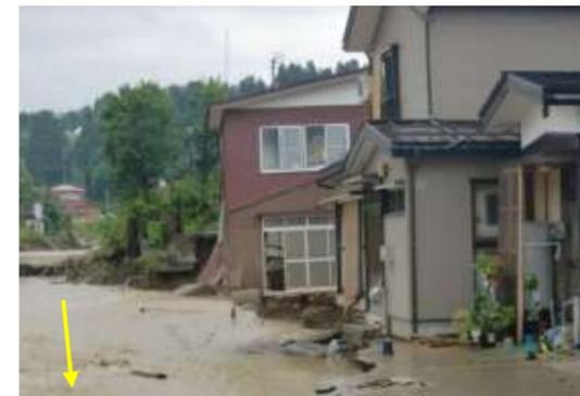
写真③ 田川2.0km左岸の住宅基礎流失
