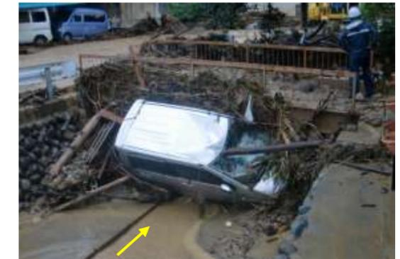
写真② 晒川0.1km付近の橋梁閉塞
