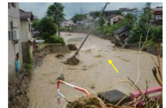
写真④ 田川橋下流左右岸の河岸侵食
