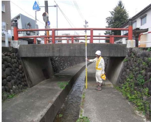
市道愛宕橋では橋梁クリアランスが不足したため、流木・土砂等の閉塞により、氾濫が発生した。
