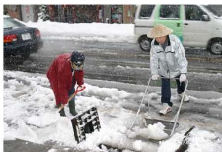
写真 2.2.4 十日町市中心部における流雪溝を用いた除雪状況
