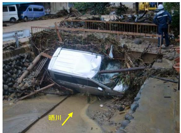
写真 4. 8. ⑥ 晒川 0. 1km 付近橋梁閉塞状況
