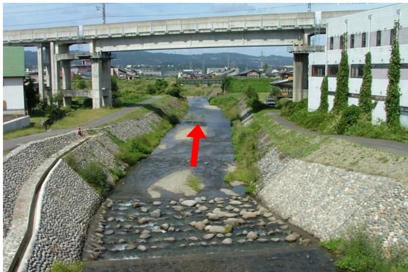
図 2.4.5 護岸、落差工整備イメージ
