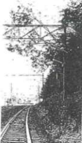
アサシノの大木が架橋に倒れかかり、国鉄中央線は上下線とも不通 (辰野町平出)
