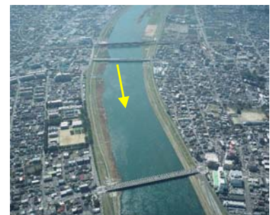
写真 2-3-7 下流区間（舞鶴橋付近）
