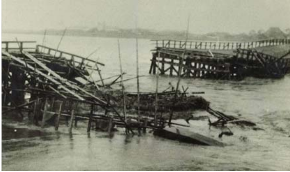
写真 2-2-3 昭和 28 年 6 月洪水 流失した舞鶴橋
