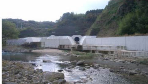
写真 3-3-4 仮排水路トンネル (平成 20 年 11 月完成)
