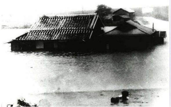
写真 2-2-5 昭和 32 年 9 月洪水 大分川明礪地区で床上まで 浸水する家屋
