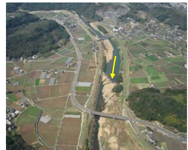
写真 2-3-12 七瀬川 (霊山橋付近)
