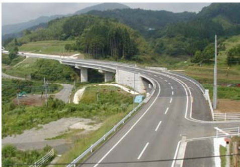
写真 3-3-1 付替国道 442 号 (平成 16 年 6 月完成)
