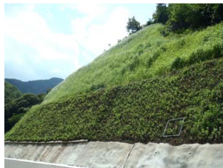
写真 3-2-4 種子吹付法面
