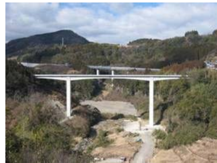
写真 3-3-2 付替市道尾原線 (平成 20 年 5 月完成)
