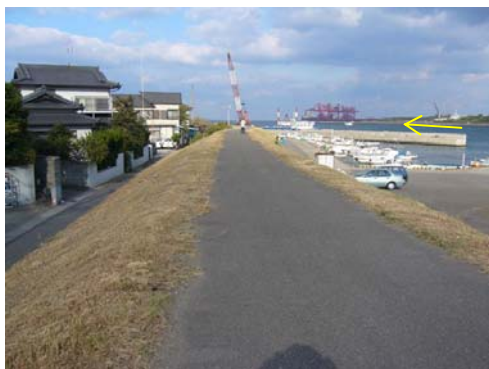
写真 2-3-1 高潮堤防状況（大分市豊海）
