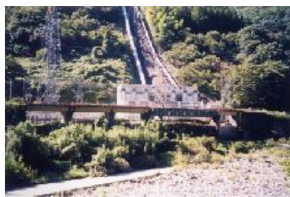
錦川第二発電所
