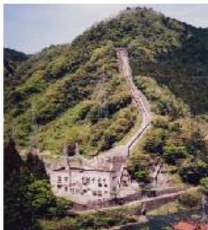
錦川第一発電所
