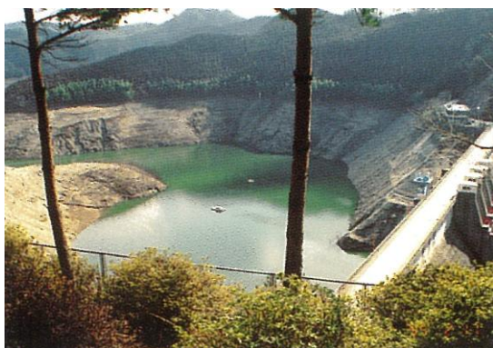
図 2.2.7 平成6年の渇水状況（菅野ダム）
