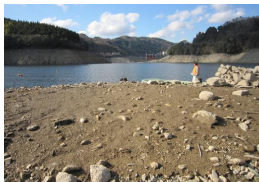
図 2.2.8 平成22年の渇水状況（菅野ダム）
