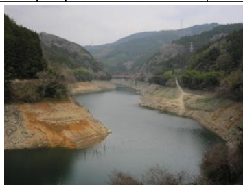
図 4.10.20 菅野ダム状況写真(平成23年4月11日撮影)
