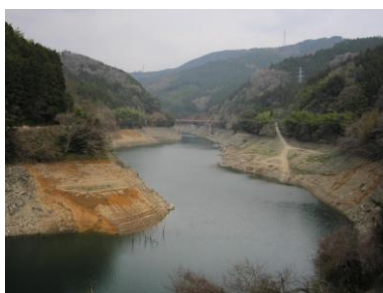
図 4.6.21 菅野ダム状況写真（平成23年4月11日撮影）
