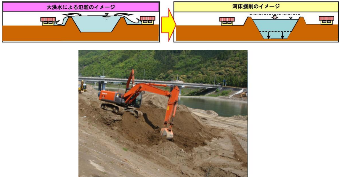
図 4.2.8 河道の掘削イメージ 河床掘削
