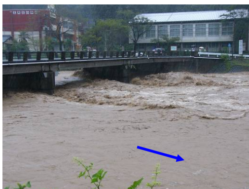
写真-③ 宮園橋付近
