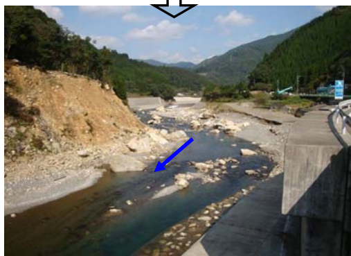
写真-⑪-4 平成 22 年時点の状況
