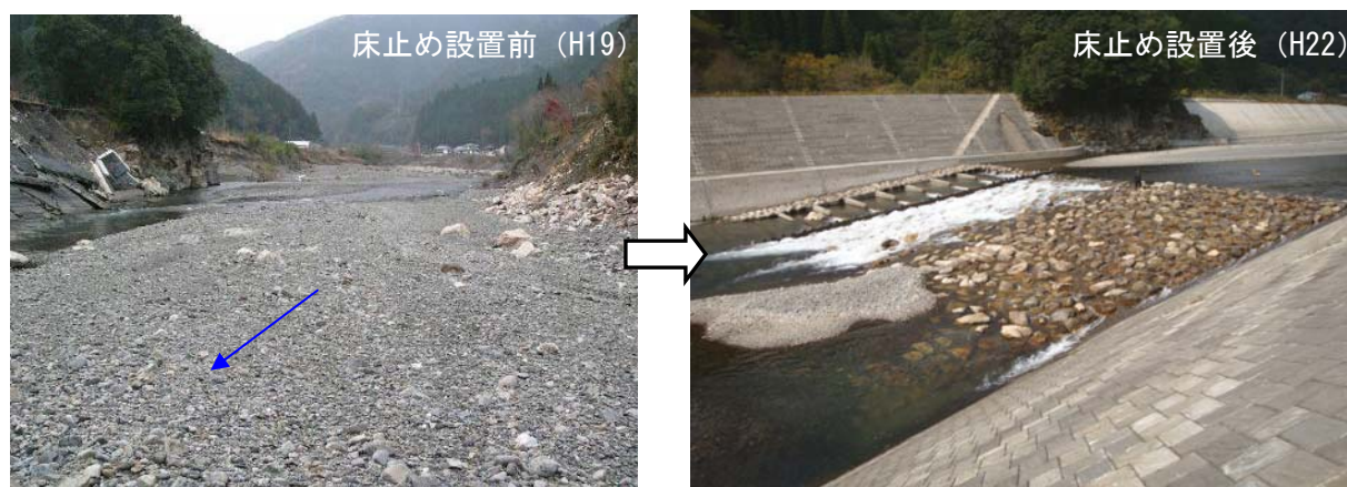
写真-⑱ 築切地区 (34K800 付近)
