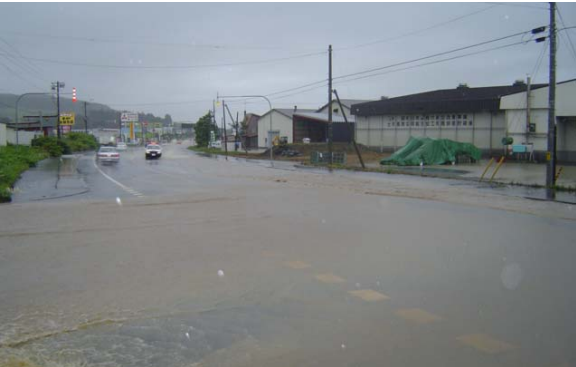
写真 1-4 平成 22 年 7 月洪水 (国道 40 号線冠水状況(士別市街における 内水氾濫状況))
