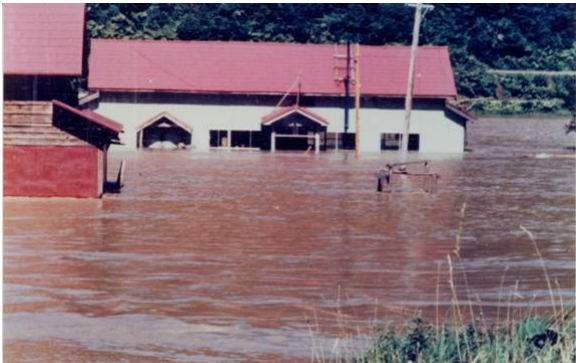
写真 1-2 昭和 50 年 8 月洪水 (天塩川 音威子府村の浸水状況)
