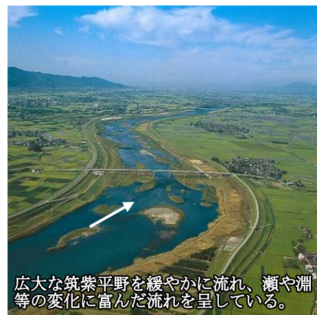
写真 2.1-10 筑後川の中流（朝羽大橋付近）
