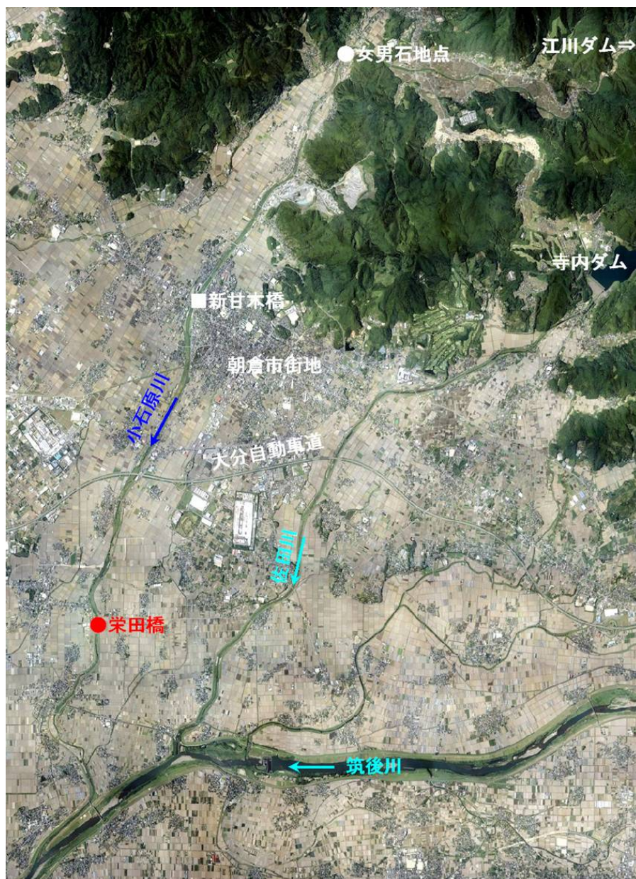
図 2.3-1 小石原川下流部の現状
