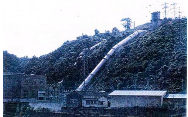
写真 2.2-5 女子畑発電所（日田市天瀬町）
