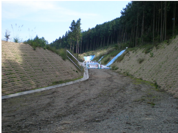
写真 3.3-3 付替国道 進入路
