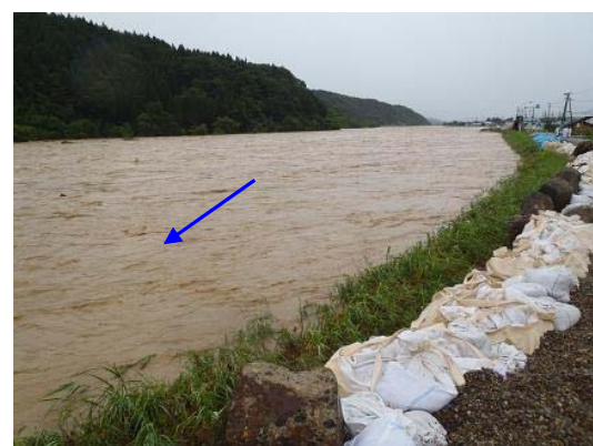
五十嵐川の水防活動による仮堤防(三条市島潟)
