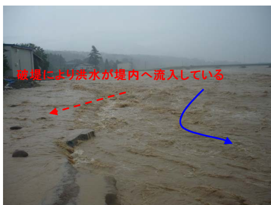
五十嵐川の破堤状況(三条市江口)
