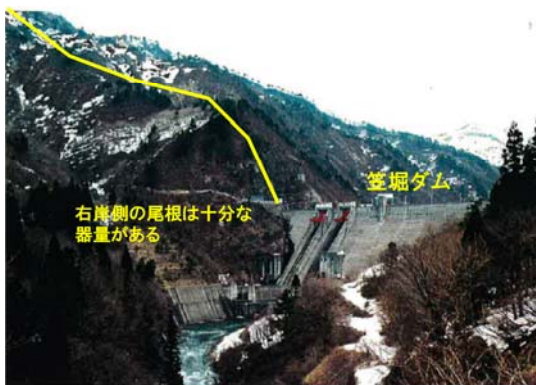
写真 4.3.2.1 笠堀ダムの地山（右岸側）
