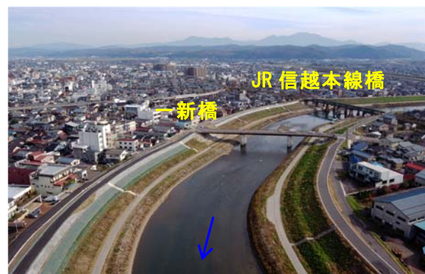
写真 2.2.5 平成16年災害復旧助成事業 による河道改修
