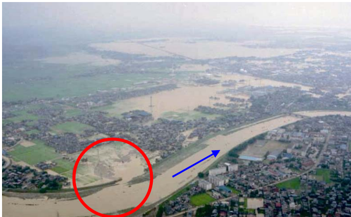
五十嵐川の堤防決壊状況(三条諏訪地区)
