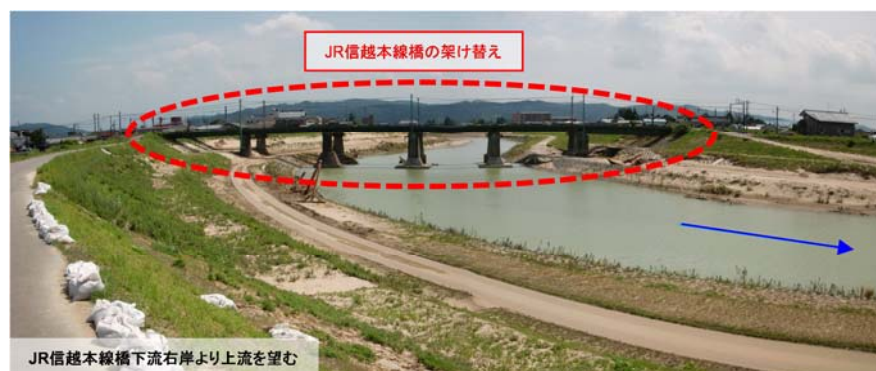
写真 4.3.3.9 JR 信越本線橋
