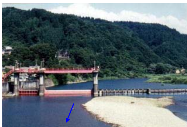
写真 2.2.10 下流部頭首工（三条市竈場）
