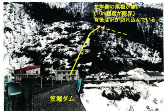
写真 4.3.2.2 笠堀ダムの地山（左岸側）
