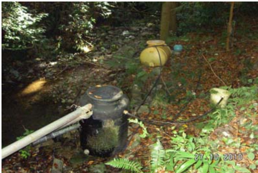
図-1.3 沢水取水の状況
