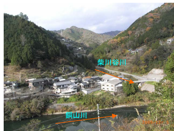
銅山川合流点俯瞰写真
