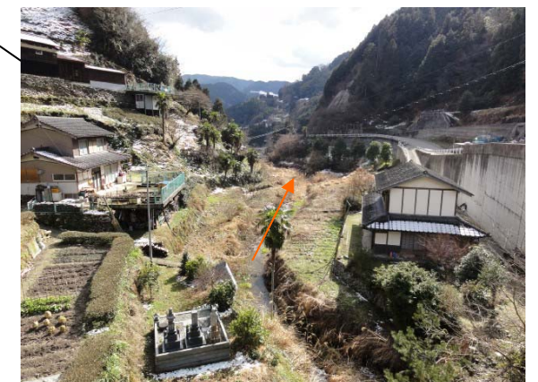
氾濫防御区域上流端付近
