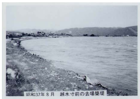
越水寸前の去場築堤
