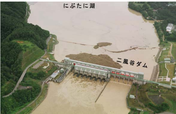
二風谷ダムの放流状況
