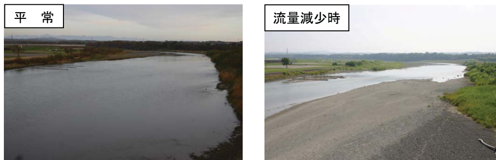
沙流川 KP2.8 (沙流川橋から上流)
