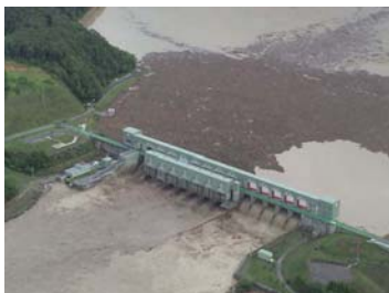
二風谷ダムの放流状況
