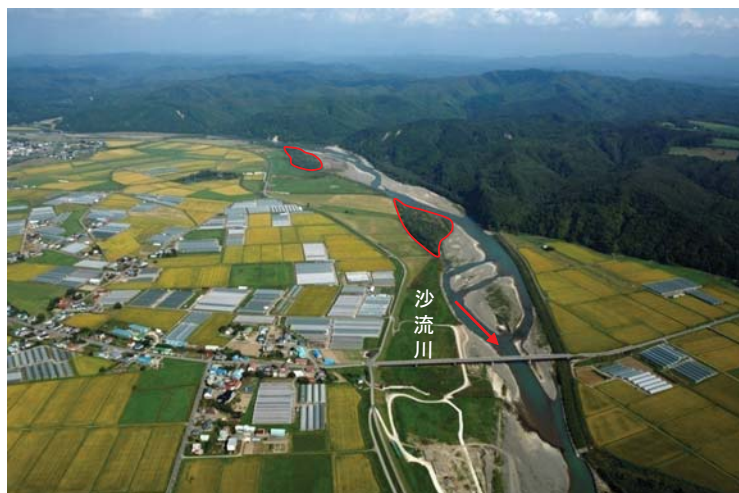
河道内樹木の状況 (沙流川 KP12.6 より上流・荷葉大橋付近)
