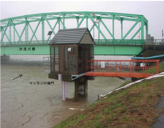
コンカン川樋門付近出水状況
