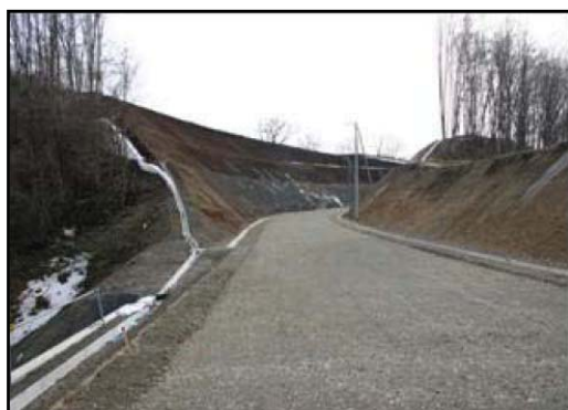
＜工事完成直後＞
