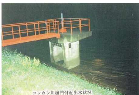
コンカン川樋門付近出水状況 コンカン川樋門付近出水状況
