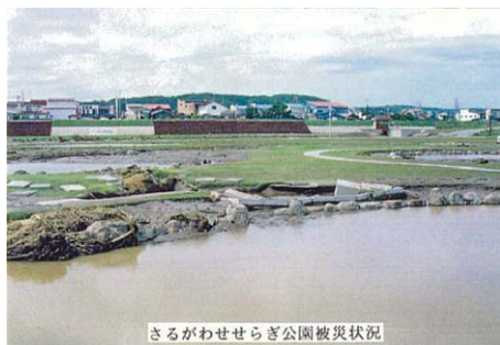
さるがわせせらぎ公園被災状況
