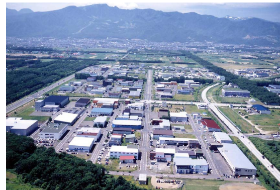
写真① 石狩湾新港地域
