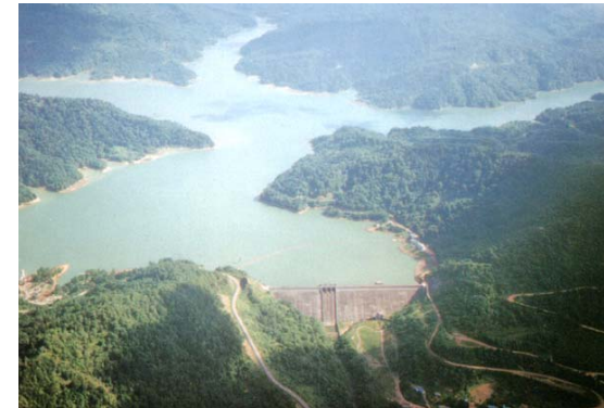
写真⑥ 桂沢ダム (昭和 32 年竣工)
