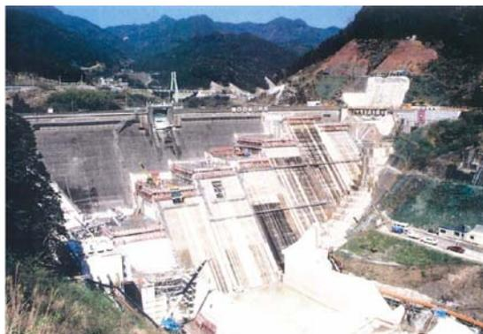
ダム下流側かさ上げコンクリート施工
