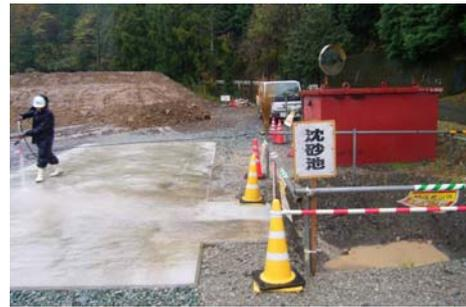
写真 3.2.6 沈砂池の設置
