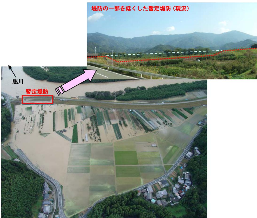
写真 2.3.2 暫定堤防からの越水による浸水状況(伊州子地区)
