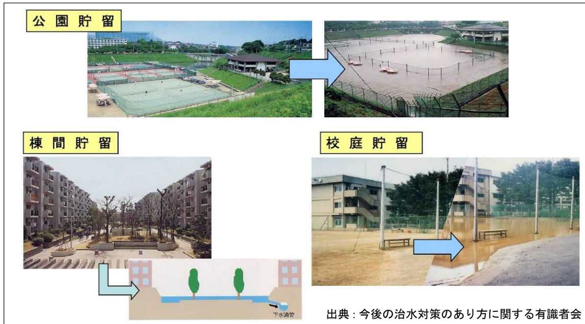
図 4.2.14 雨水貯留施設のイメージ
