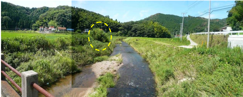
図 4.2.11 都治川・樹木繁茂状況
