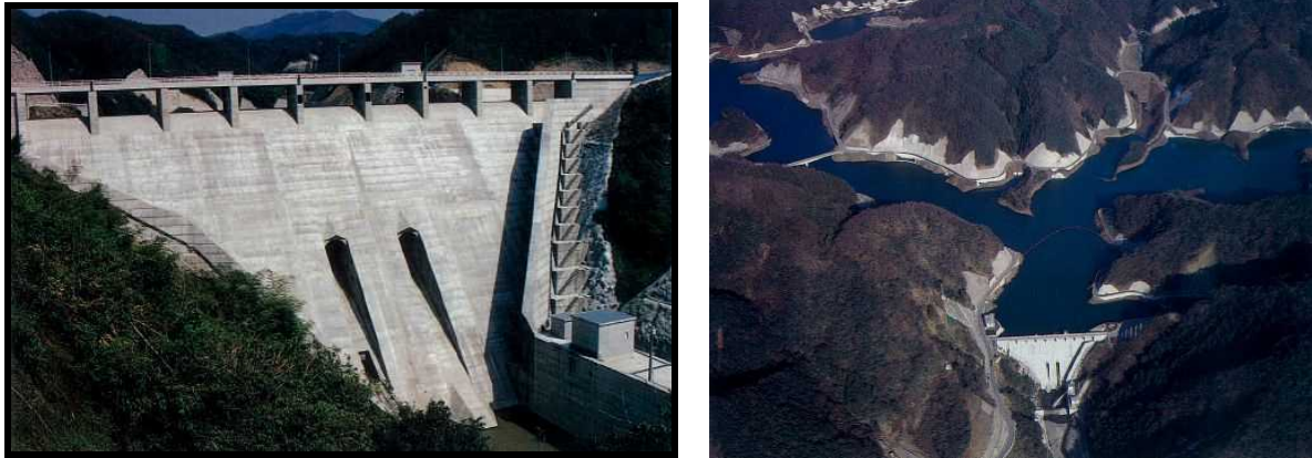
図 4.2.2 三隅川水系・御部ダムの状況
