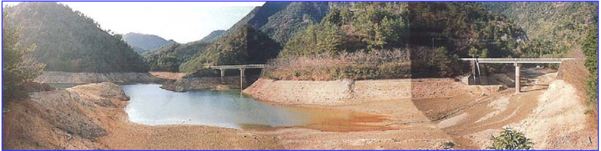
【貯水位が低下した有田ダム（平成7年3月20日の状況）】
