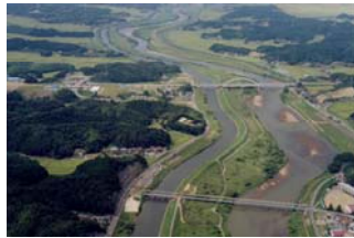
写真 2-28 背割堤の状況
