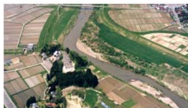
中流域の状況 (39km 付近)
