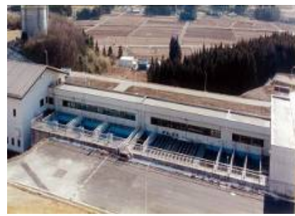
写真 2-9 なかみね 中峰浄水場
