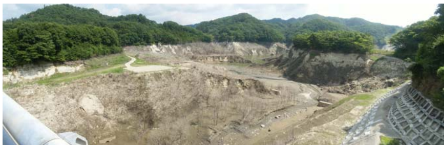
写真 2-19 干上がった「二ツ石ダム貯水池」
