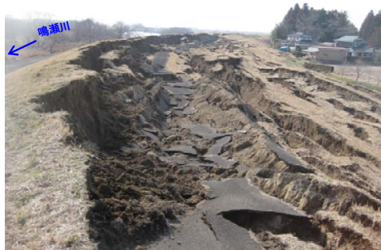
写真 2-25 鳴瀬川左岸 30.3k 付近
