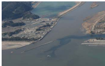
被災後河口部付近の状況
