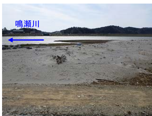
写真 2-37 河口部左岸高水敷の状況
