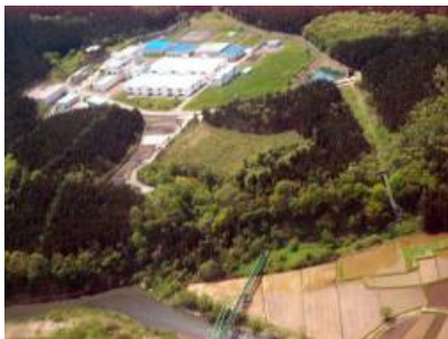
写真 2-8 ふもとやま 麓山浄水場
