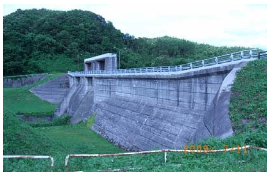
図 小羽広ダム
