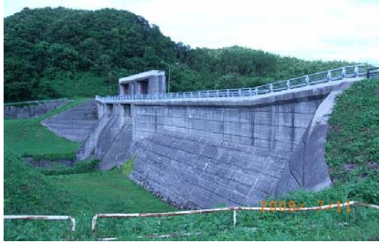
図 小羽広ダム
