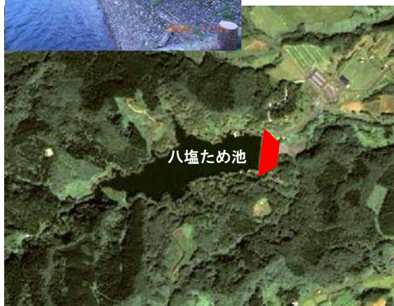
図 八塩ため池
