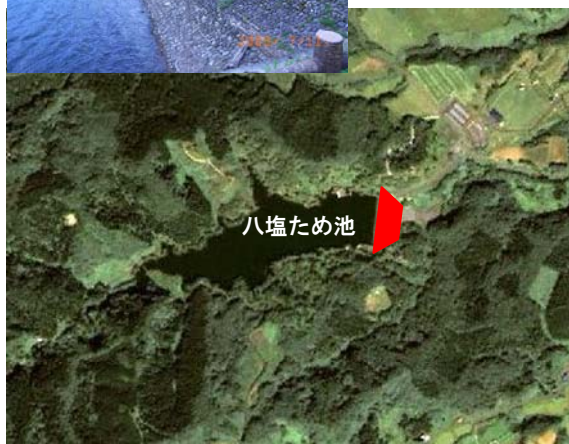
図 八塩ため池
