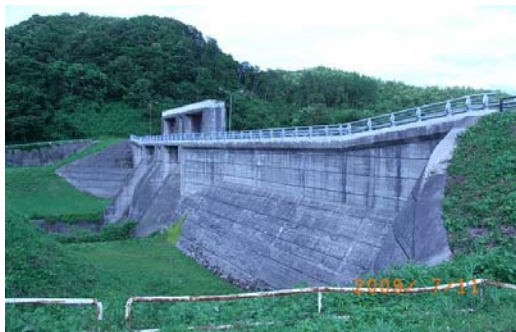
図 小羽広ダム
