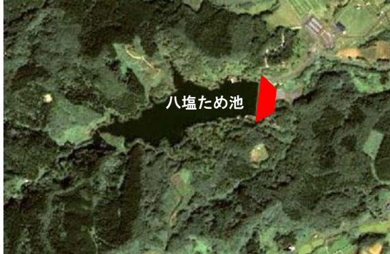
図 八塩ため池
