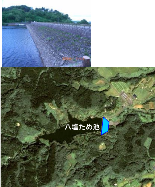
図 八塩ため池
