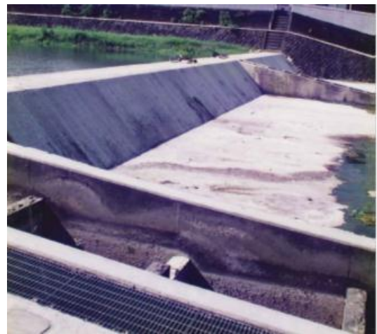
写真 2.3-6 平成6年 公園堰
