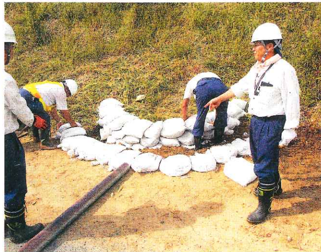
月の輪工法作業中
