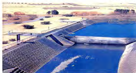
野川浄化施設
