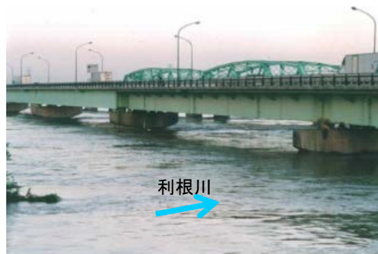
写真 3.2 埼玉県久喜市（旧栗橋町） （平成 10 年 9 月洪水）
