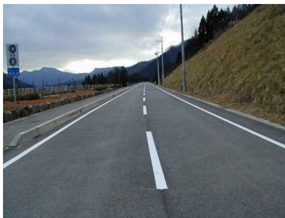
写真-3 付替県道（完成）
