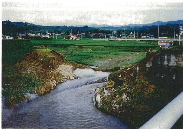
昭和63年8月 九十九川の堤防決壊状況 （花の木橋付近）
