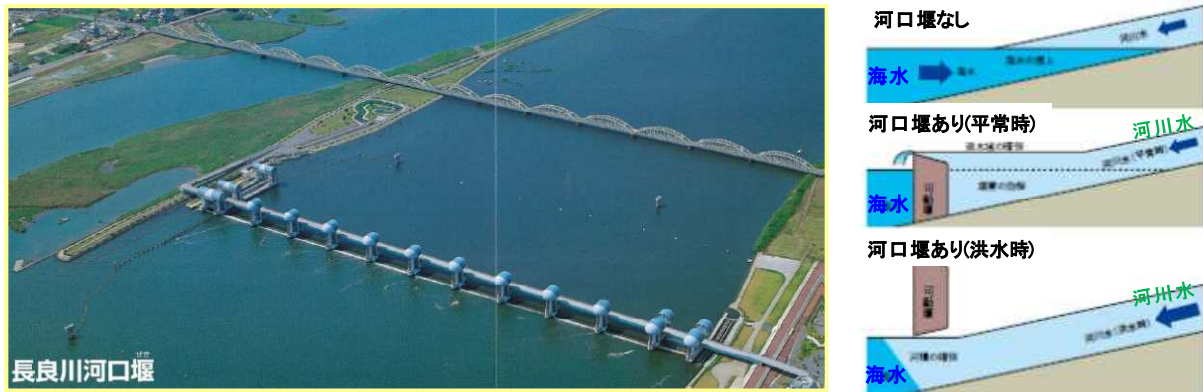
図 4.6.2 河口堰事例（長良川河口堰）
