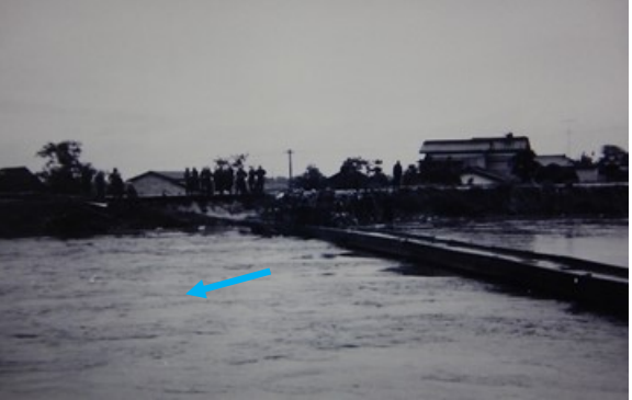
写真 1-6 昭和 47 年 7 月洪水 神代橋付近
