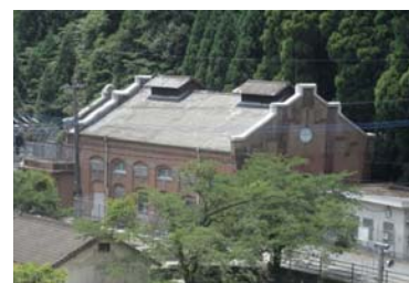
写真 1-11 広滝第一発電所
