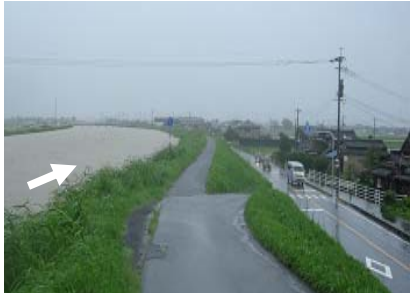
写真 1-17 平成 22 年 7 月洪水 (新村橋付近)
