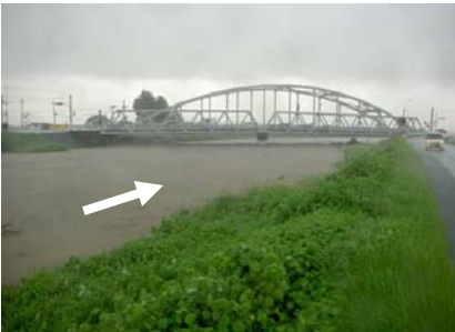
写真 1-16 平成 21 年 7 月洪水 (神埼橋付近)
