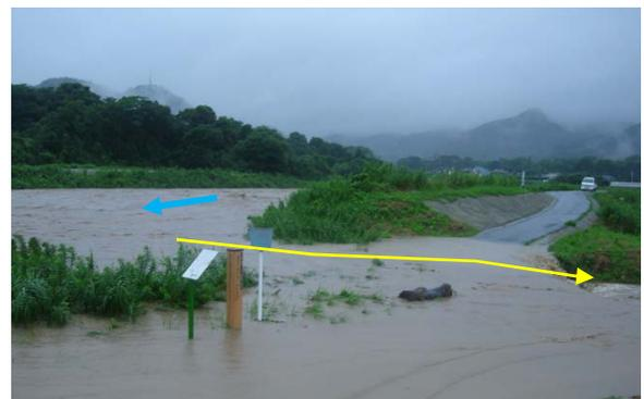
写真 2.2-37 4号野越しからの越水状況
