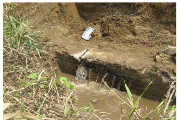
写真 2.3-8 樋管の状況、樋管函体からの漏水
