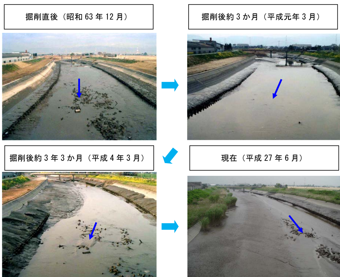
写真 2.3-6 城原川下流部におけるガタ土の堆積状況
