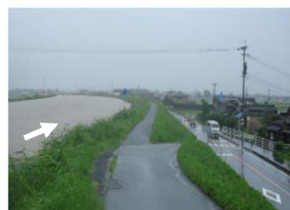
写真 2.3-2 平成22年7月洪水 (新村橋付近)
