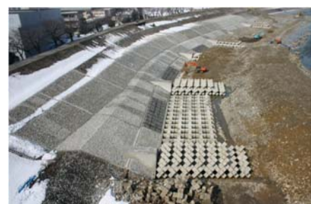
急流河川対策実施状況(根継ぎ護岸工)
