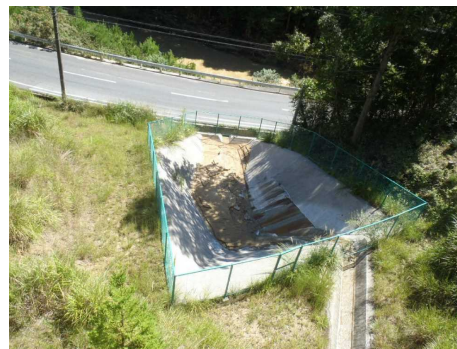
写真 3.2-1 沈砂池の設置状況
