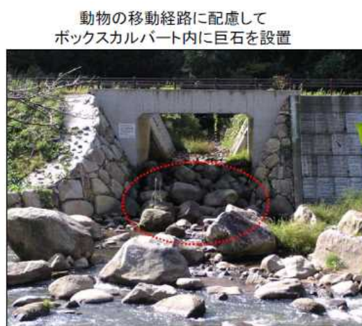
写真 3.2-2 小動物の移動に対する配慮
