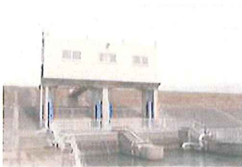
a) 利根樋管
