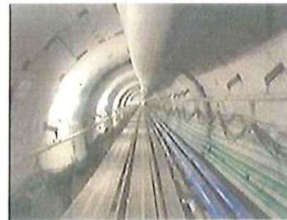
d) 石岡トンネル（建設中）
