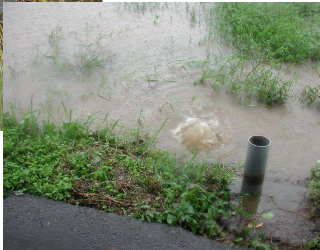
埼玉県加須市大越 漏水現場状況
