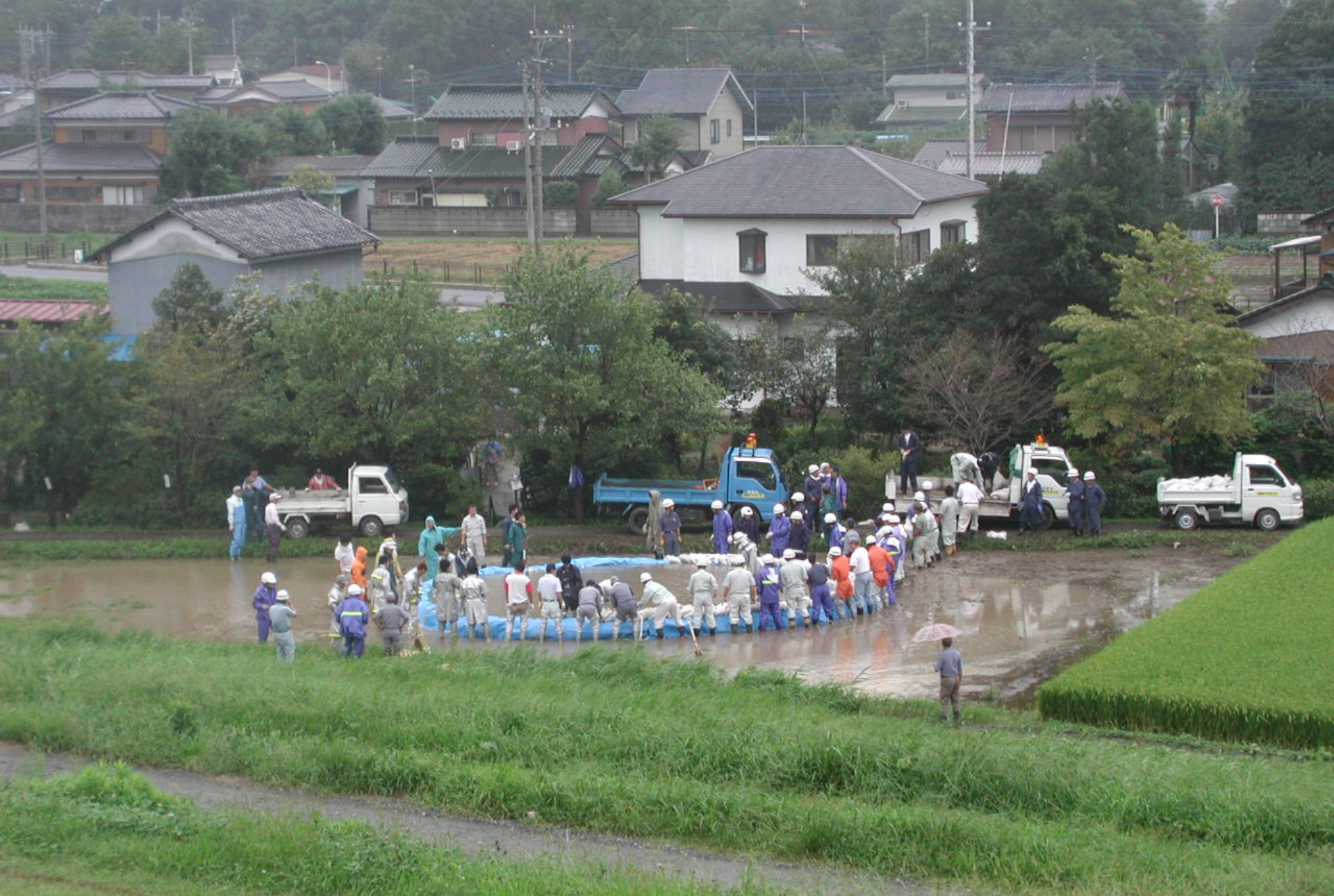
埼玉県加須市大越 水防活動状況②
