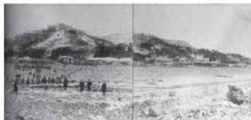
前橋市(国分土見村) 昭和12年(1937) 利根川開削工事 写真提供: (左) 群馬県建設部(右) 国土院 出典: 『国土院のあゆみ』国土院
