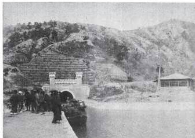
京都市山科区 琵琶湖疏水第2トンネル付近から 明治中期 写真提供：京都府立総合資料館
