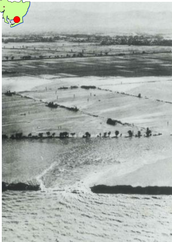
愛知県豊橋市神野新田地区の海岸堤防が決壊
