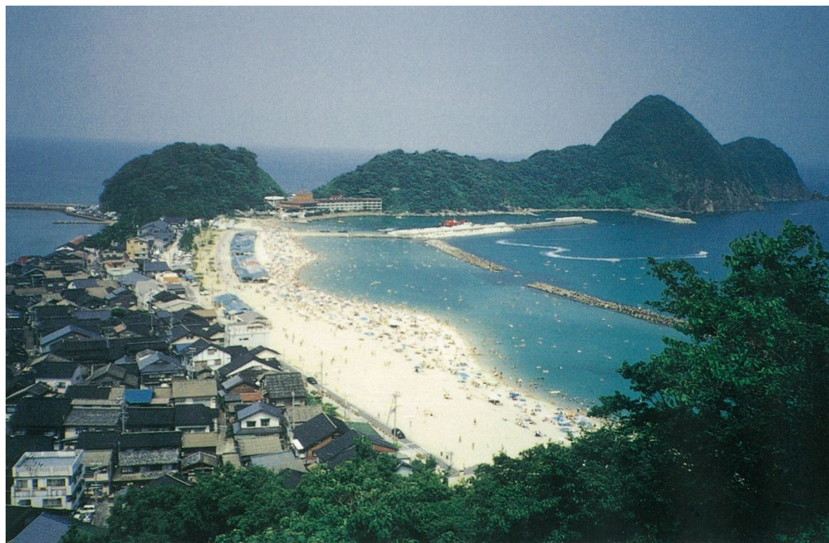
離岸堤の設置による砂浜の復元 (H7/同 海岸)
