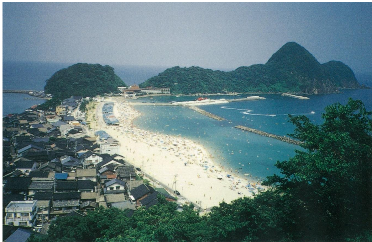
離岸堤の設置による砂浜の復元 (H7／同 海岸)
