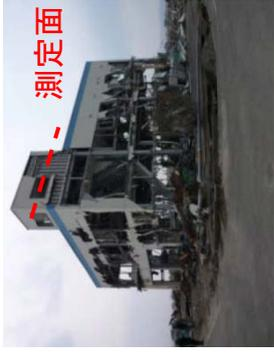
再現計算の結果（個別の建築物を考慮していない）から、式2-1を用いて $h_{fmax}$ を算定し、浸水深の実測値と比較
