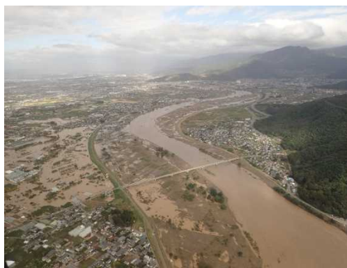
長野県長野市 被災状況
